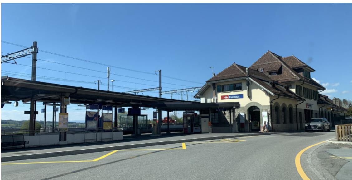
Gare de Palézieux Source : ABA PARTENAIRES SA, août 2021
